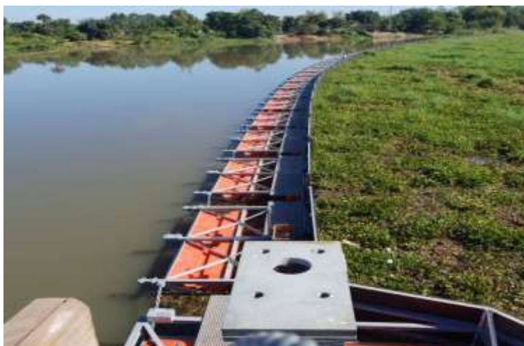
Figura 4: Plantas aquáticas com um predomínio de Jacinto de Agua preso num boom de plantas aquáticas instaladas recentemente a montante da barragem de Kamuzu no Rio Chire, no Malawi (Fonte: Peaches Phiri, 2019)
